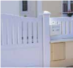
Alignement portail et barreaudage
